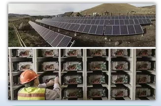
電動車電池在使用十年後, 貯電能力至少還剩70%, 利用使用過的電池來儲存風力渦輪所產生的電力, 或 是利用這些舊鋰電池來代替碳酸電池, 儲存備用電力。 「再利用」電池貯存每度電的成本僅49美元, 而新 電池要300美元。 2015 年,豐田廢舊電池用於黃石國家公園設施儲能供電,重新設計了儲能電池管理系統,208 個電池可存儲 85KWh 電能,將電池的使用壽命延長了兩倍。
